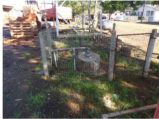
Poço artesiano existente
