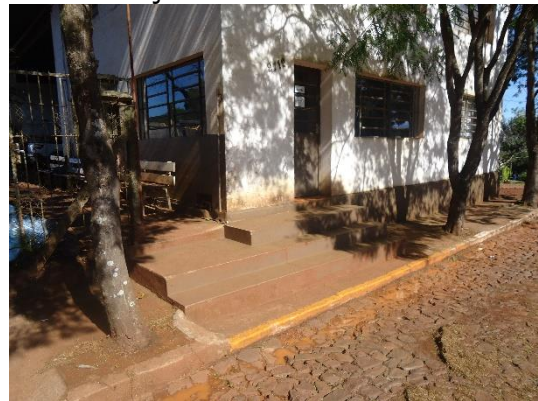
Prédio 1 – Acesso de pedestres existente
