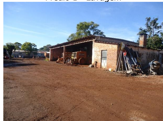
Garagem existente – a demolir
