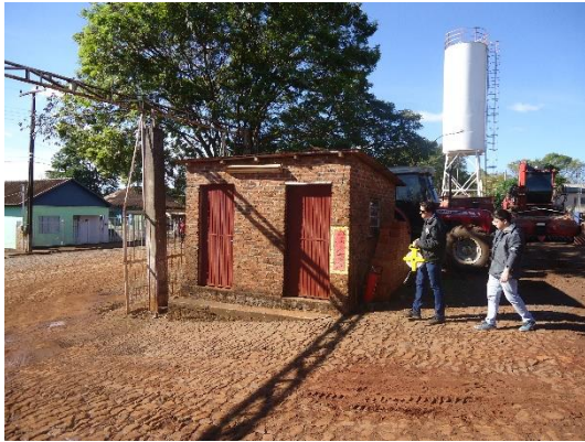
Prédio 4 – a reformar
