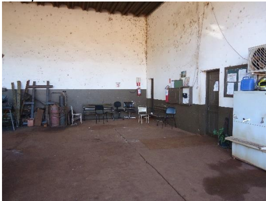
Prédio 3 – piso a reformar
