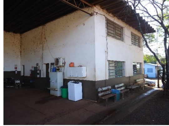
Prédio 1 – Fachada interna
