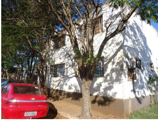
Prédio 1 – Fachada frontal
